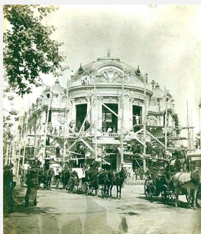
1914 г. Строежът на градския театър
